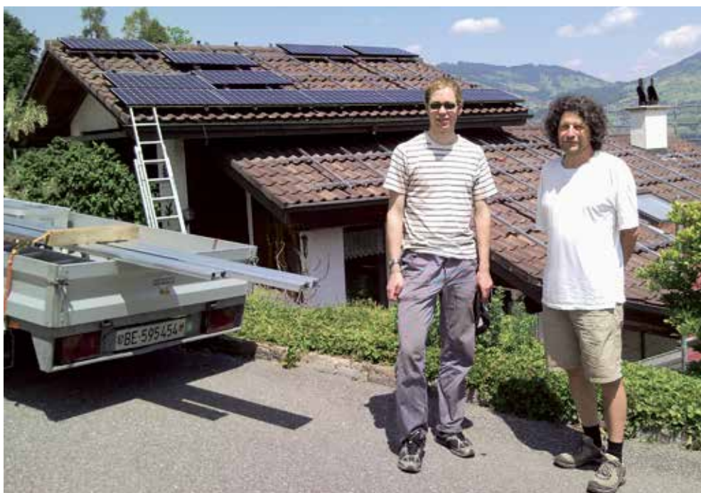
Syрил Eberhart (links), Präsident SpiezSolar, bei der Installation seiner eigenen PV-Anlage, unterstützt von Dani Brügger von der Solar-Selbstbaugruppe.
