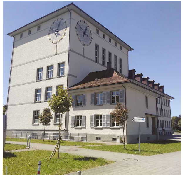
Nach Minergiestandard saniertes Schulhaus in Langenthal.
